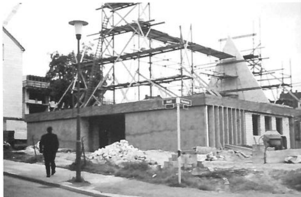
Baufortschritt an der Axstraße, August 1972
