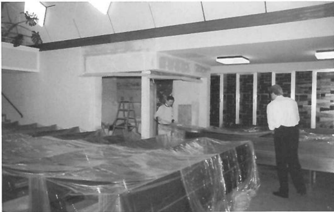
Kirchenrenovierung - die Bänke werden nach dem Gottesdienst mit Folie abgedeckt.
