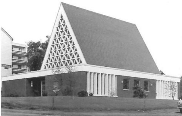
Außenansicht der neuen Kirche
